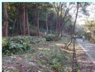
緩衝帯の整備
