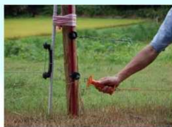
侵入防止柵の設置
