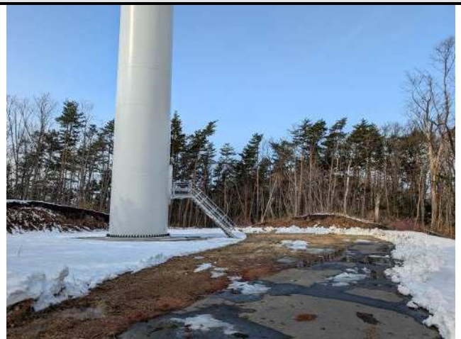
No.46WTG(測定箇所:風車基礎廻り)
