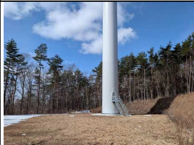
No.37WTG(測定箇所:風車基礎廻り)
