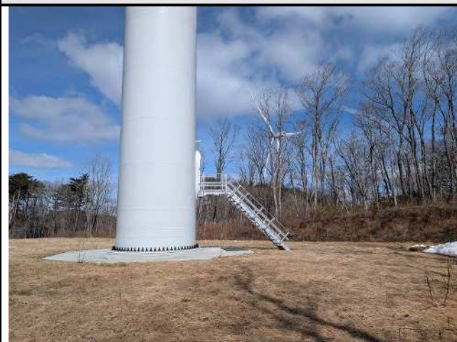
No.39WTG(測定箇所:風車基礎廻り)
