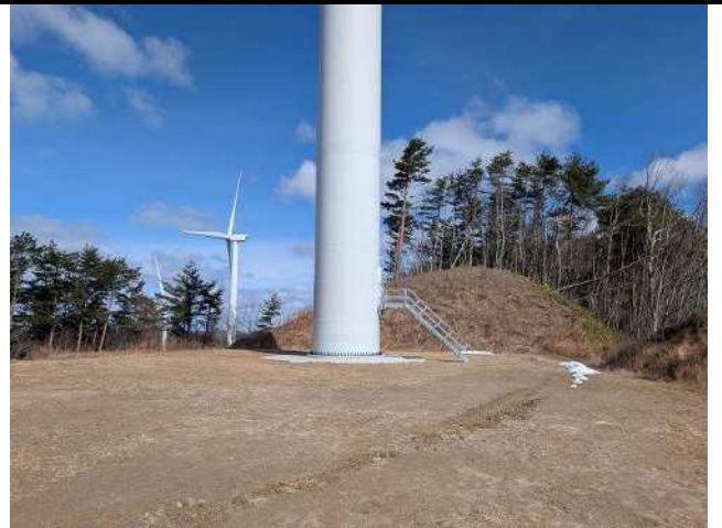
No.36WTG(測定箇所:風車基礎廻り)
