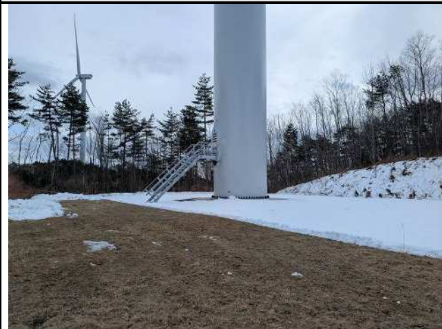
No.43WTG(測定箇所:風車基礎廻り)
