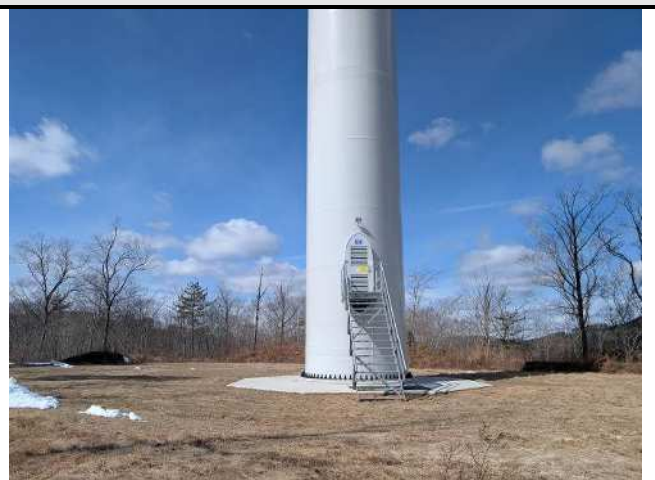
No.40WTG(測定箇所:風車基礎廻り)
