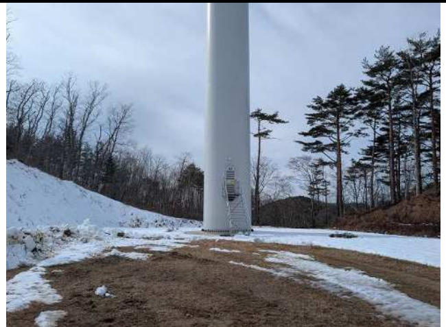
No.42WTG(測定箇所:風車基礎廻り)
