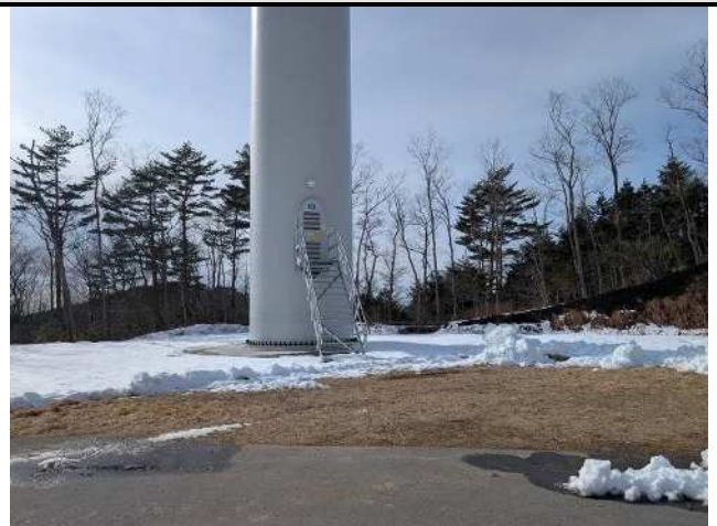
No.44WTG(測定箇所:風車基礎廻り)
