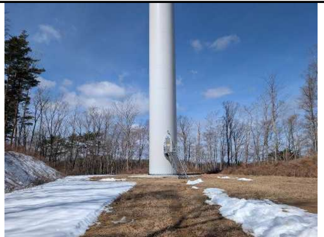
No.38WTG(測定箇所:風車基礎廻り)
