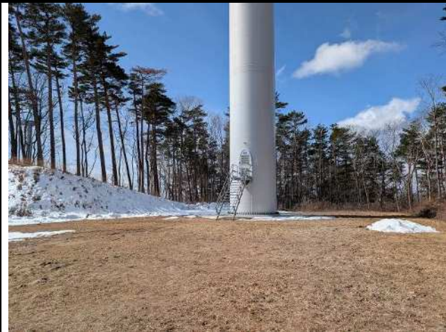
No.35WTG(測定箇所:風車基礎廻り)
