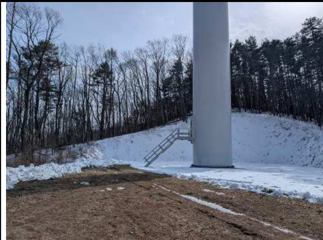
No.41WTG(測定箇所:風車基礎廻り)
