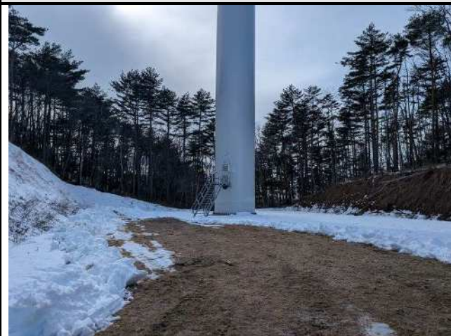
No.45WTG(測定箇所:風車基礎廻り)
