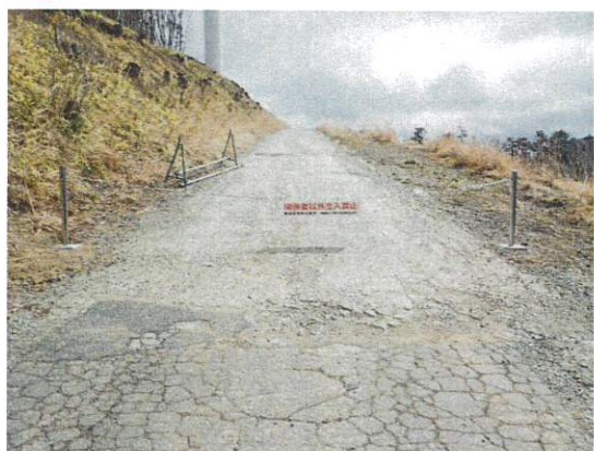
C①：発電所構内入口（WT5） チェーンゲート（施錠） Chain Gate(Locking)
