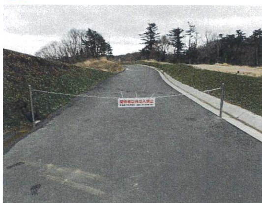
C②：発電所構内入口（WT4-1） チェーンゲート（施錠） Chain Gate(Locking)
