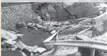
台風 13 号の被害 (平成元年)
